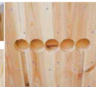
Vrtání a drážkování pro vedení elektroinstalací
