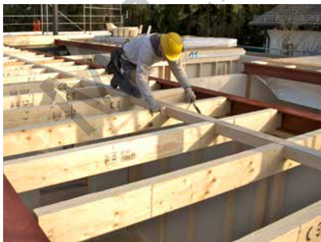
STEICO LVL R u nosné konstrukce stropu
