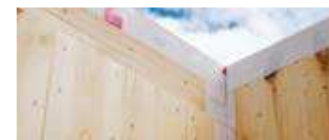
Polodrážka v panelu pro osazení stropního průvlaku
