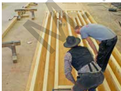
Základ stropní konstrukce STEICO LVL. Ve tvaru žebrovaného stropu bylo použito rozpětí až 12 m.
