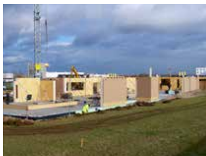
Instalace prefabrikovaných stěnových a stropních prvků. Díky vysokému stupni prefabrikace se stavební činnosti nemusely přerušit ani v zimních měsících. Budova tak mohla být dokončena za pouhých 10 měsíců.
