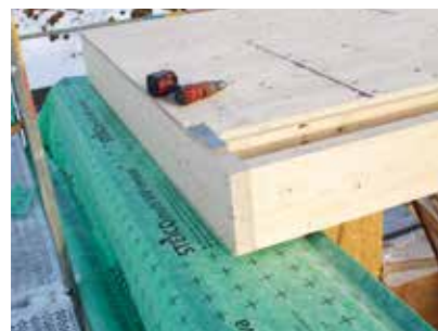
Instalace prefabrikovaných stěnových a stropních prvků. Díky vysokému stupni prefabrikace se stavební činnosti nemusely přerušit ani v zimních měsících. Budova tak mohla být dokončena za pouhých 10 měsíců.
